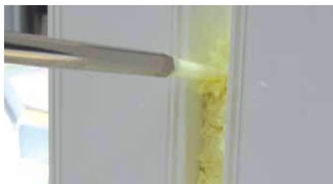
Fot. 03: Wypełnienie szczeliny pianą DuPont™ Insta Stik™ Flex+
