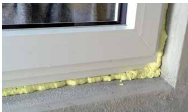
Fot. 04: Utwardzoną pianę DuPont™ Insta Stik™ Flex+ można przyciąć
